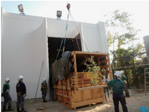
図7 輸送箱を設置している様子
