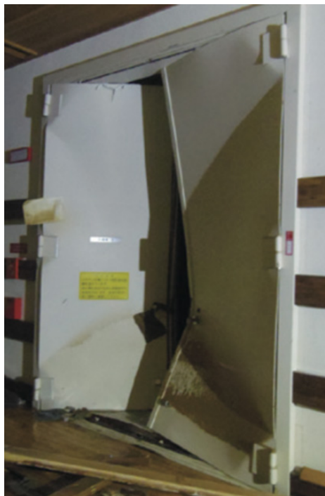
図4 破壊された第3収蔵庫の扉
