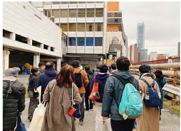
図2 「小田急百貨店解体工事現場見学の様子」
