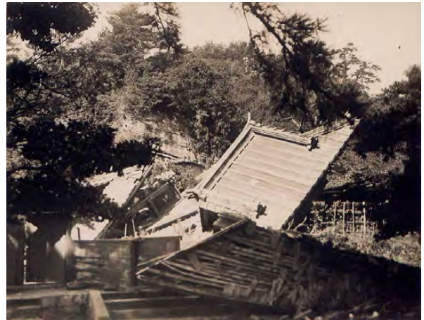
図5 英勝寺山門（左奥）と鐘楼（右手前） 鎌倉市中央図書館 いずれも現重要文化財
