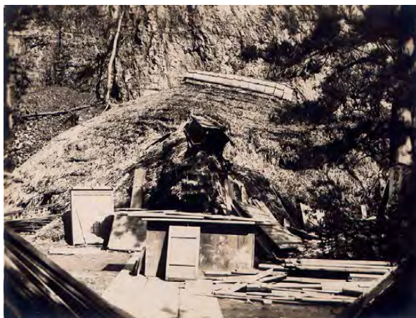
図2 安養院（本堂か）鎌倉市中央図書館 地震と崖崩れで建物が全潰した。
