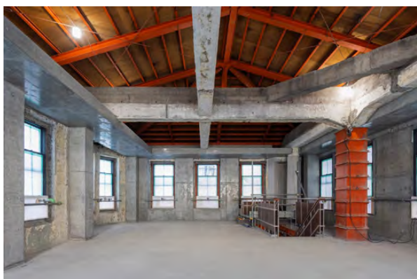
図12 耐震補強完了時の2階.
