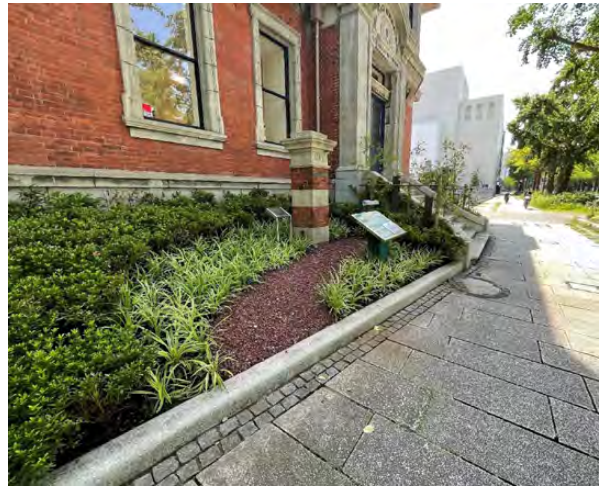
図24 改修後の外構。
