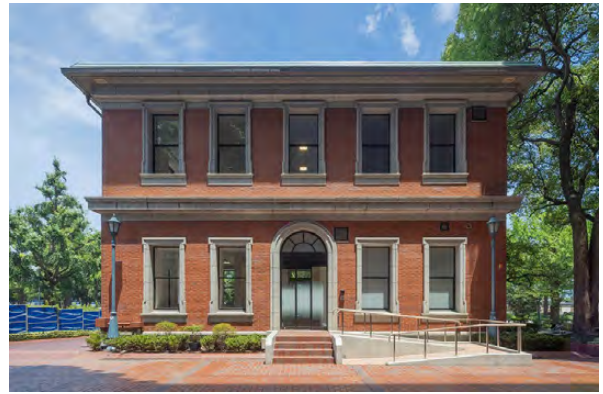
図20 裏側出入口にスロープを新設.
